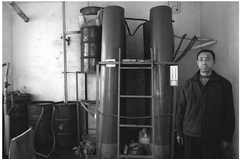
簡単な設備によって鉄とマンガンを取り除く炭礫水浄化装置
