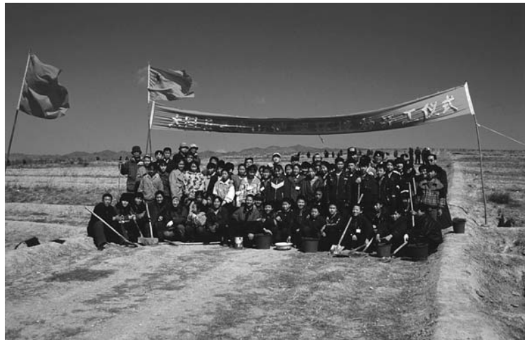
采涼山プロジェクトの起工式。1本の木もなかった
