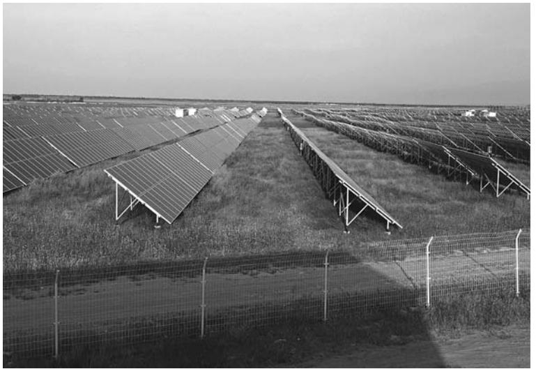
塩害地に設置されたメガソーラー。これから急速に拡大する
