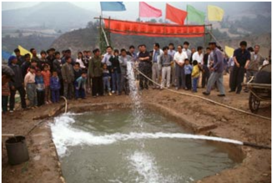
靈丘県石瓮村で井戸掘りに協力した。通水式ではみな大喜びだが……。
